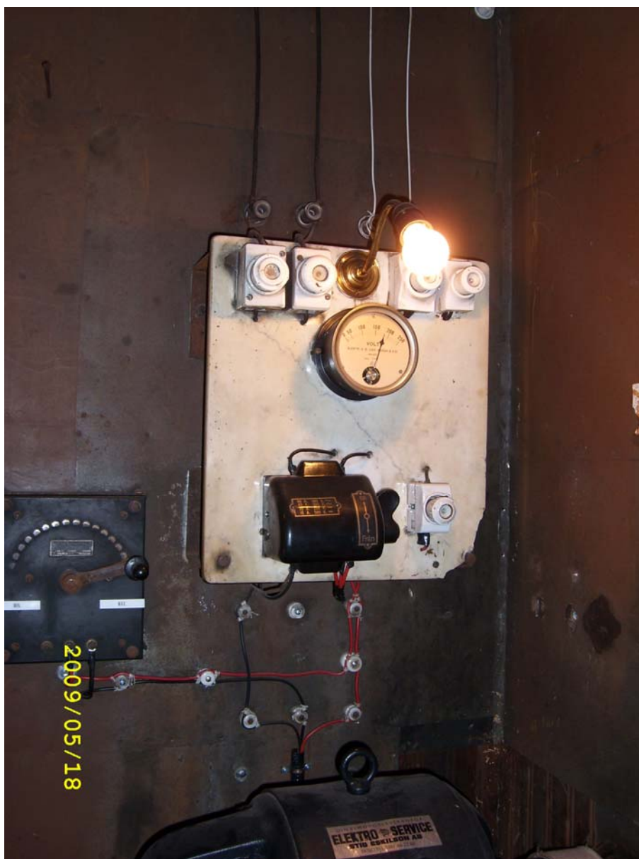
Figur 12. Mätartavlan med tillhörande shuntmotstånd.
