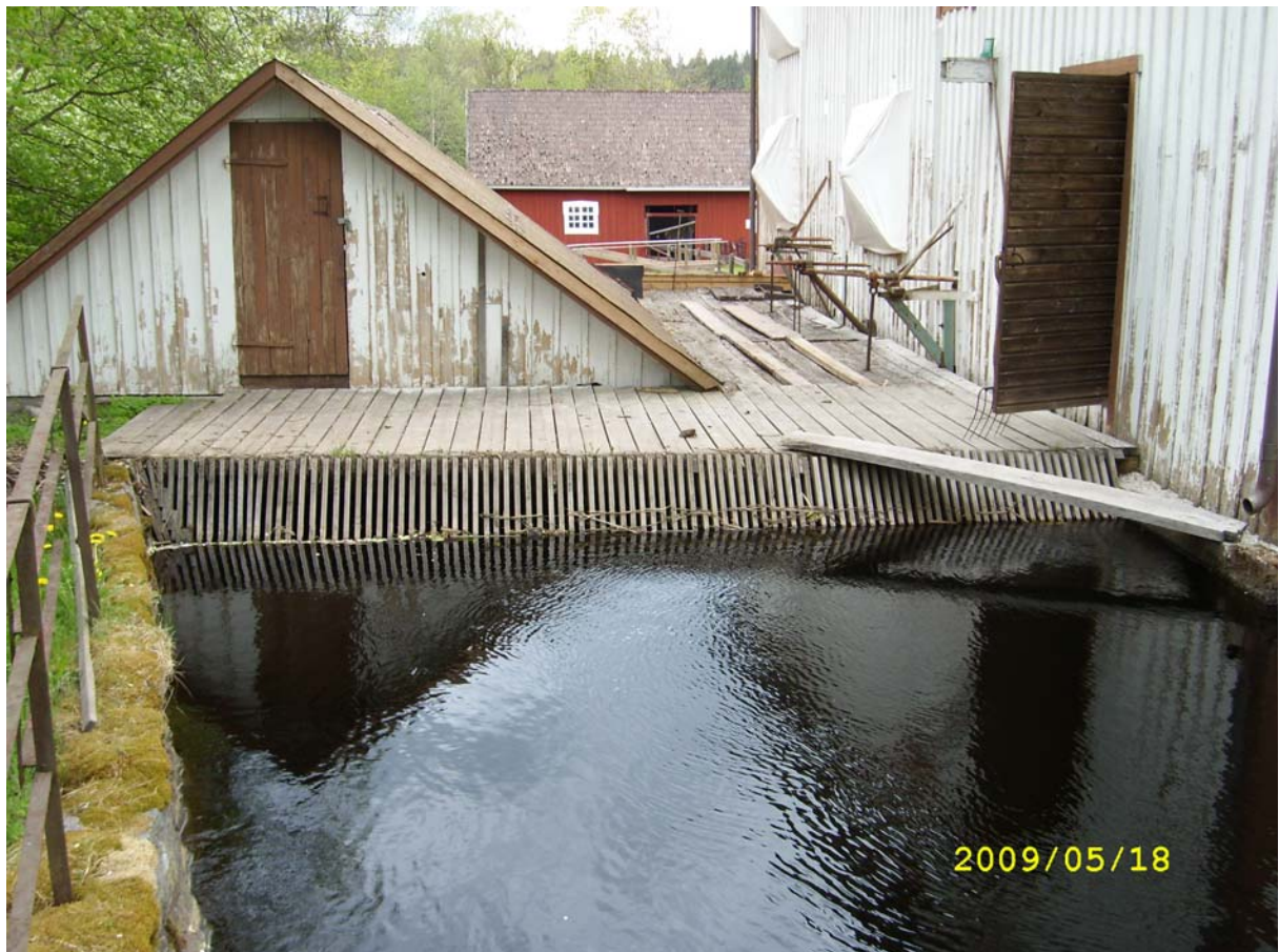
Figur 14. Intaget till turbinsumpen bakom kvarnbyggnaden.
